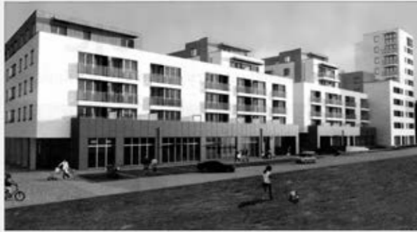
Mieszkania, apartamenty i lokale użytkowe w osiedlu Dywizjonu 303 przy ul. Fr. Hynka
